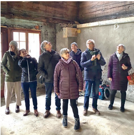
AKTIONÄR*INNEN AUF DER BAUSTELLE IM EHEMALIGEN RESTAURANT BETTLIORN.
