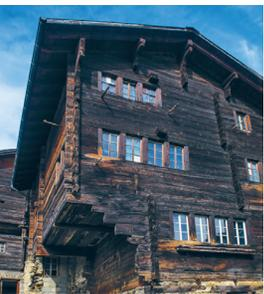
weit vorkragende Vorschutz mit abgetreppten Wandbalken an der linken Traufseite über dem untersten, nur einraumbreiten Sockelgeschoss. Die zwei oberen Stockwerke sind im Vorderhaus durch Wandgwätze in Stube und Kammer unterteilt. Das erste Stockwerk wurde 1963 von der
