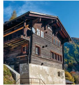
17. Jahrhunderts. Am Blockwerk befindet sich an der Schauseite unter der Fensterreihe des 1. Geschosses ein Konsölchenfries und die Pfettenkonsolen sind mit Rossköpfen verziert. An der linken Traufseite ist im 2. Geschoss der Loibe-Balkon erhalten geblieben. Ursprünglich dienten beim Walliserhaus die Räume des 2. Geschosses, die Loibe (Laube), als Schlafräume. Später wurde das Loibe-Geschoss mit dem Anstieg der Bevölkerung oft zu einer Wohneinheit ausgebaut.
