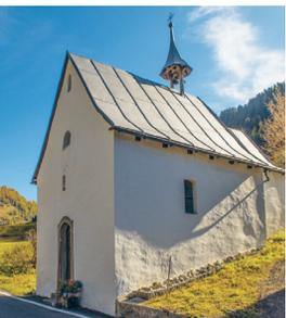
Herkunft) stammt aus dieser Zeit. Am Giebel der Kapelle steht die Jahreszahl 1734 – vielleicht das Baujahr des Schiffs. Die nach Süden gerichtete Kapelle steht giebelständig direkt an der Strasse. Das rechteckige Schiff und der eingezogene Rechteckchor werden überdeckt von leicht geknickten Satteldächern. Überhöht wird
