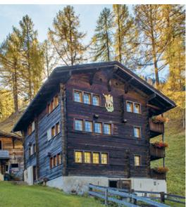
Baudatum die Jahreszahl 1699. Der Friesschmuck am Blockwerk besteht aus Würfelfriesen unter Wolfszahn. An der rechten Traufwand wurden unter der Abschleppung des Satteldachs später Lauben angebaut. Das Vorderhaus wird im 1. und 3. Geschoss mit Wandgwäthen in Stube und
