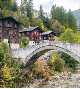
Die am östlichen Scheitel der Brüstungsmauer 1564 datierte Bogenbrücke ist das eigentliche Wahrzeichen von Schmidgöschere. Die in einem eleganten Bogen über die Binna führende, aus Tuffstein und vermörtelten Bruchsteinen gefügte Brücke entspricht im Stil der Schärtbrücke (Objekt 9). Die Brücke ist vermut-
