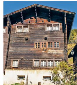
gekuppelte Fensterreihe original erhalten. Der Laubenanbau unter der Abschleppung des Satteldachs an der rechten Traufwand wurde vermutlich zur gleichen Zeit als Kammerachse mit den Wohneinheiten verbunden.
