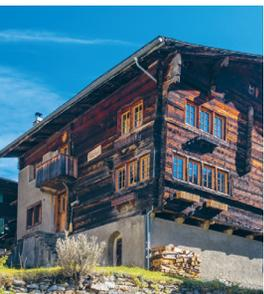
Kantholzblock im 2. Geschoss und im Dachgiebel mit Wandgwäthen unterteilt und gefestigt. An der rechten Traufwand waren ursprünglich Stall und Speicher angebaut, die abgerissen und durch einen Wohnteil ersetzt wurden.
