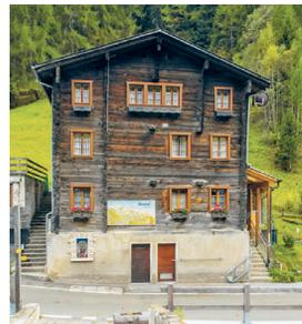
Nebenräumen. Die ursprüngliche Fensteranordnung aus gekuppelten Fensterreihen und Einzelfenstern wurde nachträglich durch Fenstervergrößerung verändert.
