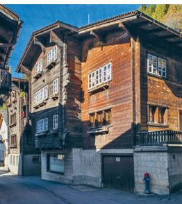
Der Blockbau, der an der Strassenseite über den Mauersockel vorkragt, ist in verschiedenen Bauetappen entstanden: Ein spätmittelalterliches Haus wurde 1584 um zwei Stockwerke erhöht. Das Blockwerk dieser Aufstockung bildet über der linken Traufseite des untersten Wohnstockes einen auf Blockwandkonsolen abgestützten Vorschutz. An der rechten Traufseite war ursprünglich unter einem Pultdach ein Ökonomieteil angebaut. Dieser Anbau ist zu Beginn der
