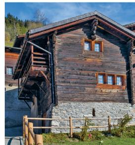
unter der Abschleppung des Satteldachs eine Laube angebaut. In der Stube ist das Baudatum 1528 in grossen römischen Ziffern eingekerbt. 1790 (Jahreszahl am Türsturz der Eingangstür) wurde das Haus renoviert. An der Schauseite ist das Blockwerk verziert mit einem Rillenfries. Auffallend sind die über der Giebelfassade getreptt vorstehenden Pfettenkonsolen.
