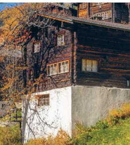
der Abschleppung des Satteldachs offene Lauben angebaut (auf 1. Geschosshöhe mit ursprünglichem Hauseingang?). Das 1. Geschoss mit den gekuppelten Fenstern dient mit Stube und Küche als Wohngeschoss, das obere Geschoss mit spärlicherer Befensterung als Schlafkammern.
