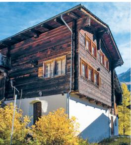
Das beachtliche Haus steht abseits der Dorfgasse inmitten von Nutzbauten. Erbaut wurde das aus Blockwerk und einem am Hinterhaus bis zur Dachlinie gestuften Mauersockel bestehende Haus 1611. Es ist 1½-geschossig mit Wohnstockwerk und Lobe-Geschoss. An der Schauseite krägt das Blockwerk auf einem
