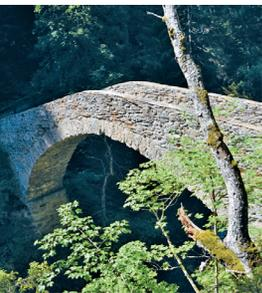
Die Schärtbrücke ist eine aus Tuffstein und vermörtelten Bruchsteinen gefügte Bogenbrücke mit einer Spannweite von 15.5 m. Sie führt als Teil des Albrunwegs (der «Heerstrasse» nach Gengiols) kurz vor der Twingischlucht über die Binna. Erbaut wurde die elegante, im Volksmund «Karls des Grossen» genannte Brücke
