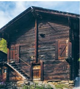
bäudeachse ausgesparten Eingang zugänglich. Diese Anordnung entspricht der inneren Raumaufteilung mit seitlichen Läger für die Kühe. Beidseits des Stalleingangs ansteigende Balkentreppen mit kleinen Laubenpodesten erschliessen den Heuspeicher. Die Eingänge der
