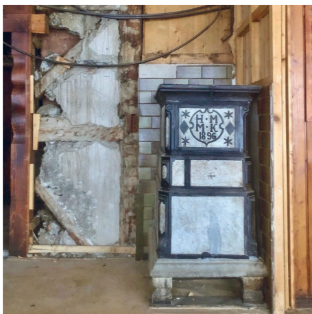
FREIGELEGTES RESTSTÜCK EINER RIEGELWAND IM EHEMALIGEN SAALGESCHOSS.
