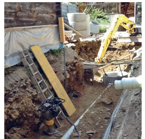
DAS VERLEGEN DER LEITUNGEN IM ALTEN DORFKERN WAR EINE HERAUSFORDERUNG.
