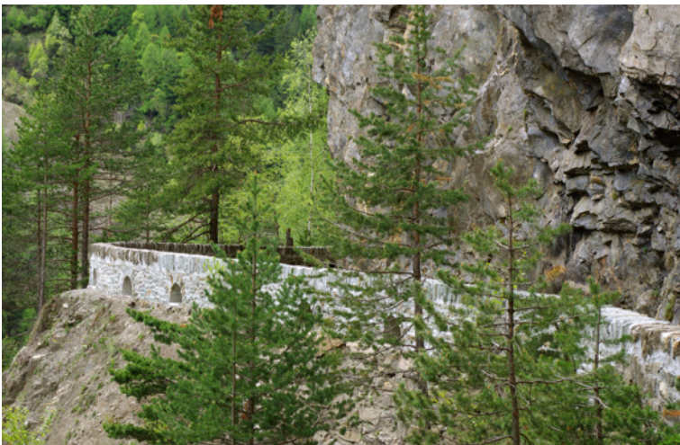
Sämtliche Begrenzungsmauern entlang der historischen Strasse wurden saniert oder neu gebaut.
